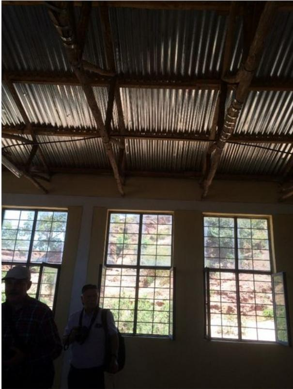
Hier: Decke eines Klassenraums mit solider Dachkonstruktion aus Hölzern und Wellblech.
